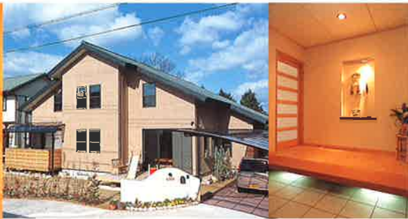
写真右／白壁の飾り棚には、雑穀をあしらった人形が。 写真中／外装はサイディング。外断熱工法により、保温性は抜群だ。 写真左／階段には桧の集成材が効率よく用いられている。 ●設計・施工／山の加工場ネットワーク TEL.0593・85・6002
