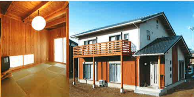
写真右／外壁は、一階部分がスギ板、上部はサイディング張りとした。オーナー自らの手で自然塗料を塗れる高さにと考えたため。
