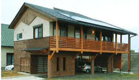
写真右下／一階をスギ板張り、二階を塗り壁とした外装。構造材は鉄筋だ。屋根には太陽光発電システムを搭載する。
