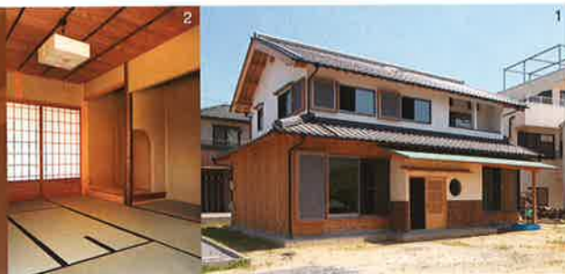
1/1階をスギ板張り、2階部分を漆喰仕上げとした外観。撮影時は戸袋が未装着。 2/茶室の用もなすよう炉が切られた和室。リビング、寝室も畳敷きだ。 3/スギの踏み天井とされた2階廊下。吹き抜けから、階下の気配が感じられる。
