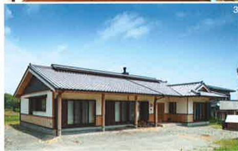
1 / リビングから見た玄関土間。8帖あるので、薪ストーブ、MTBを置いて、愛犬がゆったりくつろげる。 2 / ロフトの建具を開ければ、風が廊下と自在に行き来する。 3 / 瓦屋根の上に載った鋼板の越屋根が、小屋裏の熱や湿気を放出する仕組み。深い軒が日射を遮り、雨をしのいで木部を守る。 ●設計・施工 / (有)青木工務店 TEL.0598-34-0835 ●納材 / 松阪飯南森林組合 ●建築坪単価 約68万円
