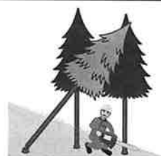
(図3) かかっている立木の伐倒
