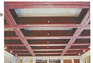
予め工場で用意されたパネルを、現場で組み立てる。
