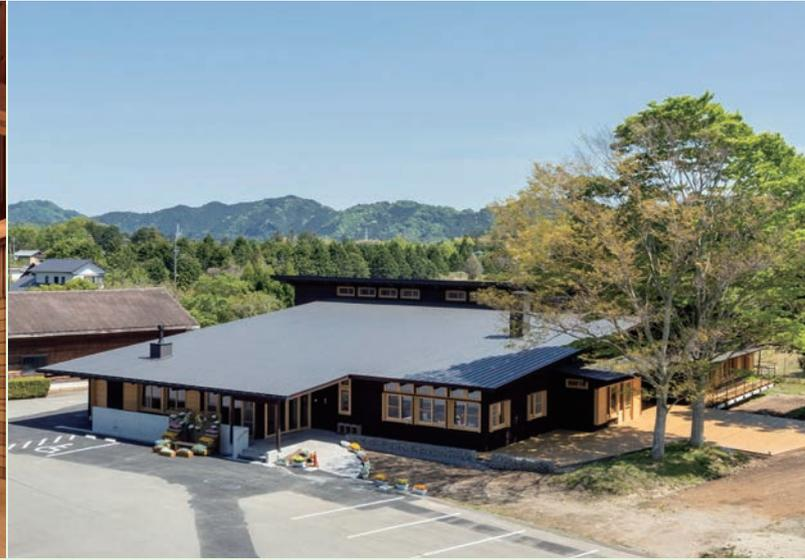
三重県林業研究所の敷地内に教育環境を備えた施設として2023年竣工。内装に県内各地の木材を用いて、見た目や触り心地を体感でき、環境に配慮した部材を利用。全ての柱に尾鷲ヒノキのFSC®認証材を使用している。
